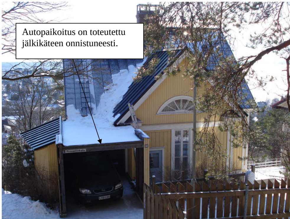
Kuva 6. Rinne vaatii usein mielikuvitusta siinä miten auton paikoitus tontille toteutetaan. Tässä tapauksessa auto on sijoitettu talon laajennusosaan. Autopaikoituksen toteutustavoissa tulee olla joustoa myös jatkossa.
