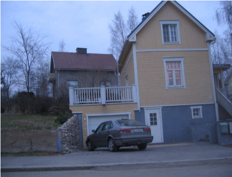
Kuva 34. Onnistunut autotallilaajennusratkaisu Hyhkystä. Autotallin päälle on luotu tasainen oleskelutila. Autopaikotuksen mahdollistaminen tonteille vapauttaa ahtaita teitä liikenteelle.
