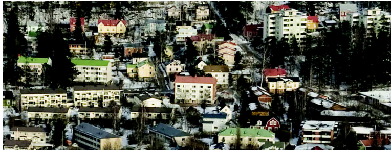
Kuva 16. Tällä Ylä-Pispalan / Tahmelan arvoalueella on yli 15 kpl kerrostaloja 1800 ja 1900 luvulta, joiden korkeudet vaihtelevat 2-6 kerroksen välillä, lisäksi ko. taloissa on myös kellarit. Pispalassa on perinteisesti myös pienkerrostaloja. Lisäksi samalle alueelle on mahtunut myös yli 10 kpl rivitaloja. (Kuva: Lentokuva Vallas 2008, http://suomi.ilmasta.fi )
