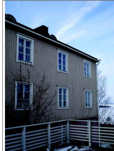
Kuva 18.a) Rinne mahdollistaa rakentamisen useaan kerrokseen maisemaan sopivasti. Kuvan rakennuksessa on 5 kerrosta.
