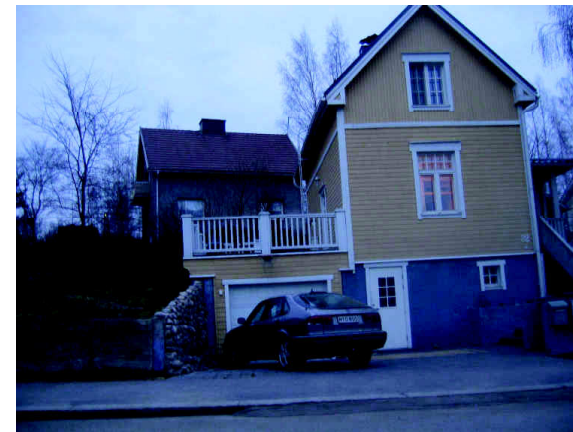
Kuva 34. Onnistunut autotallilaajennusratkaisu Hyhkystä. Autotallin päälle on luotu tasainen oleskelutila. Autopaikotuksen mahdollistaminen tonteille vapauttaa ahtaita teitä liikenteelle.
